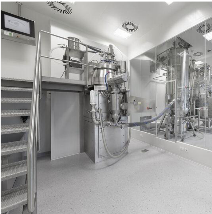
Glatt-Pharmaanlage in reinraumgerechter Gestaltung (Copyright: Andreas Suetterlin)
